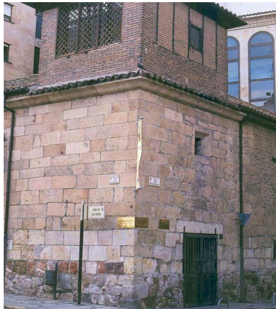
La sede de la filmoteca salmantina, en el edificio histórico de Casa de Viejas
